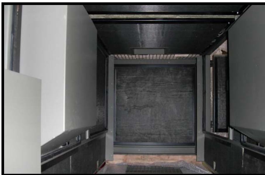
Imagen 5- Interior de un Grupo Electrónico insonorizado
